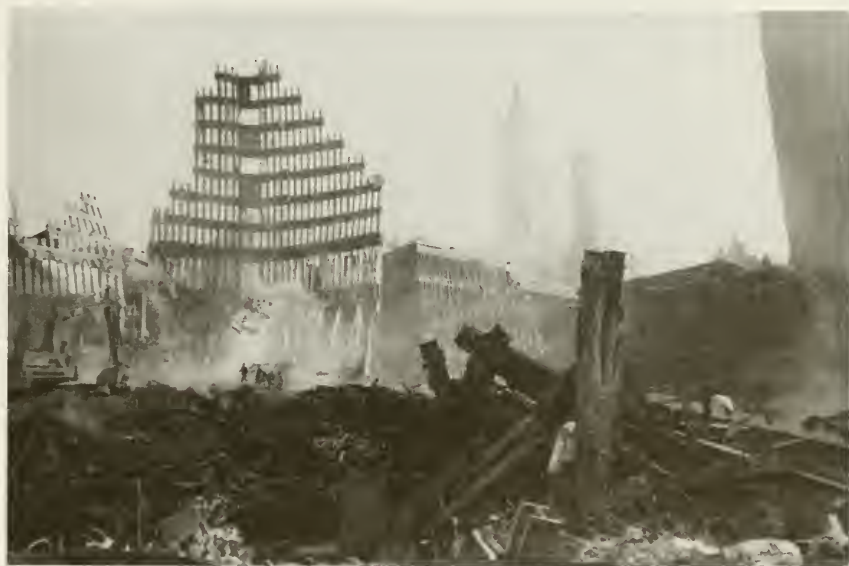
20. Спасательно-уборочные работы на месте разрушенного Мирового торгового центра. Стр. 234
