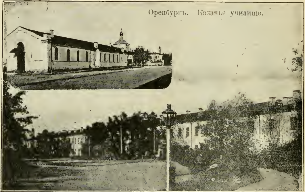
Видъ Оренбургскаго Казачьяго военнаго училища. Вверху — Зимній манежъ для волтижировки. Вдали его — училищная церковь. Внизу — корпусъ зданія. Прямая аллея — постоянный выходъ юнкеровъ въ городъ и церковь.
